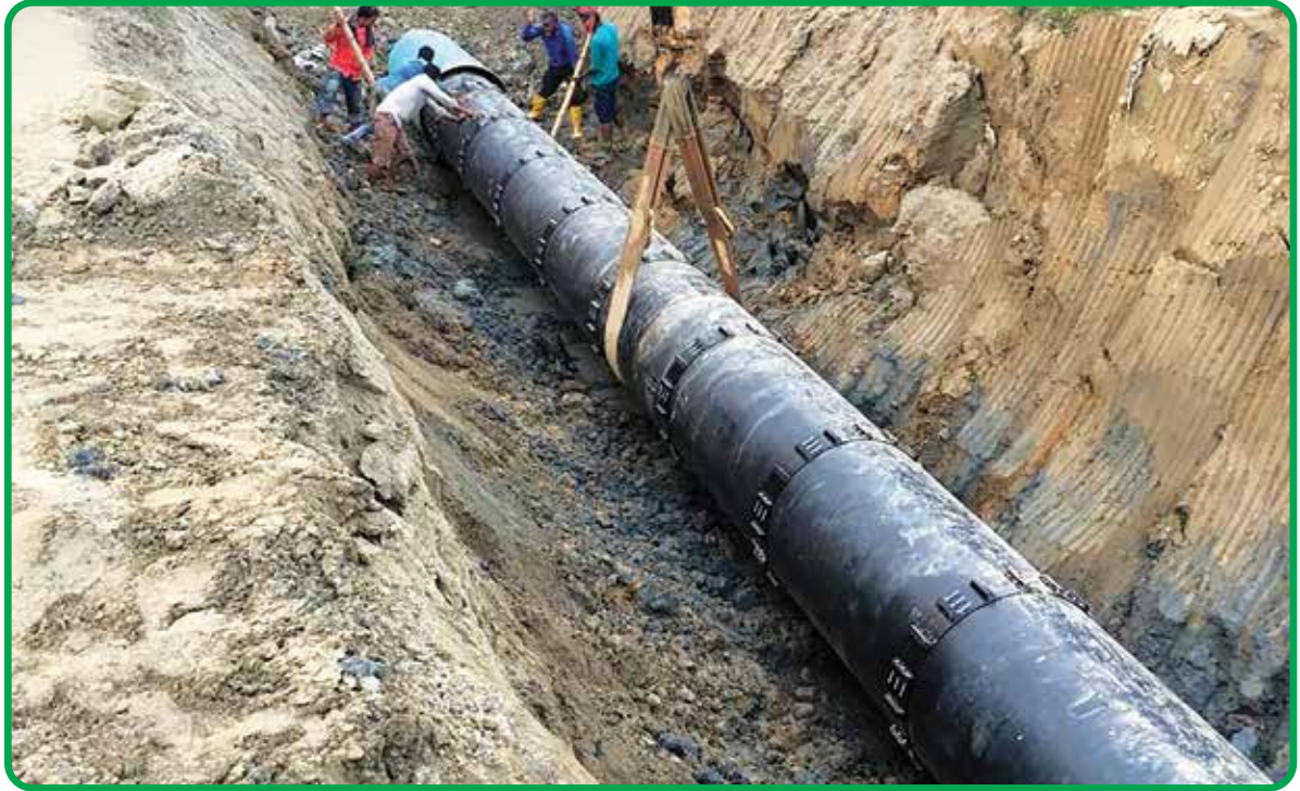
চট্টগ্রাম-ফেনী-বাখরাবাদ প্রকল্পের রোড ক্রসিং কার্যক্রম
