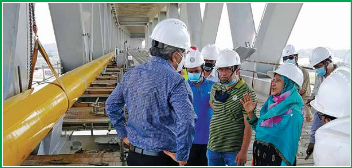
ব্যবস্থাপনা পরিচালক মহোদয় কর্তৃক পদ্মা বহুমুখী সেতুতে গ্যাস সঞ্চালন পাইপলাইন নির্মাণ কার্যক্রম পরিদর্শন
